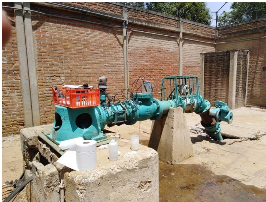
Figura 3-3 Medición de parámetros físico-químicos de campo en el pozo Azcapotzalco 1
