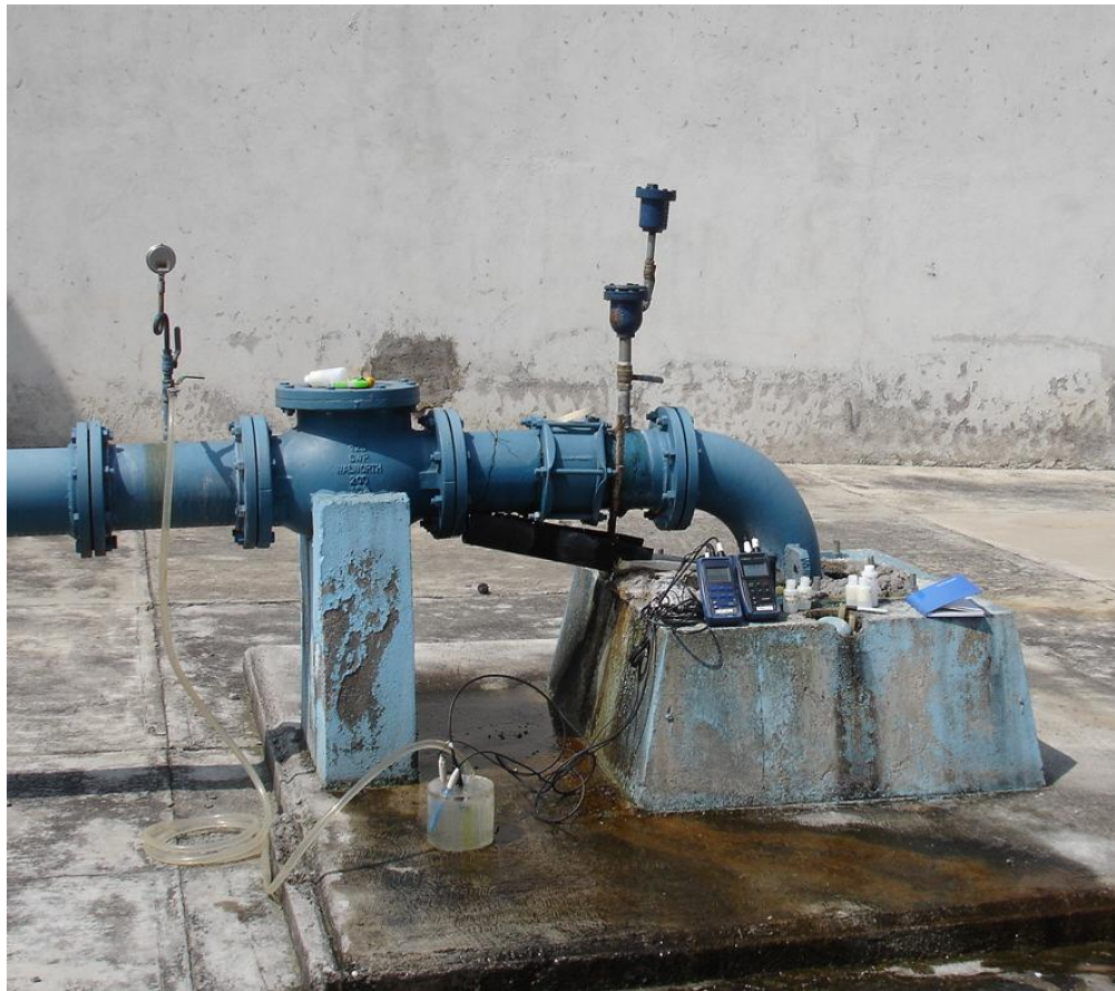
Figura 6. Tubería instalada en el tren de descarga del pozo para garantizar la obtención de muestras inalteradas de agua, representativas del flujo subterráneo, acordes con los protocolos de laboratorio para el análisis de parámetros físicos, químicos e isotópicos.
