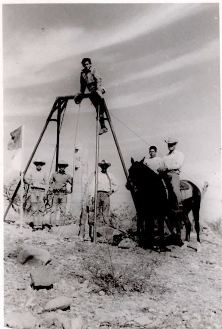
No.7.- Vista hacia el N.E. Muestra el Mto. No. 117 A antes de ser pintado.
