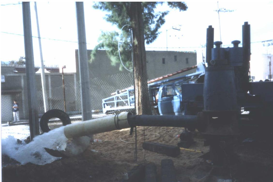
Foto N° 2 y 3.- Se observa el desarrollo de las pruebas de bombeo a caudal escalonado, la descarga del agua se condujo en forma no apropiada por un tubo de PVC y desecho de tinacos de asbesto, hacia el drenaje para evitar influencia de esta agua hacia el pozo.
