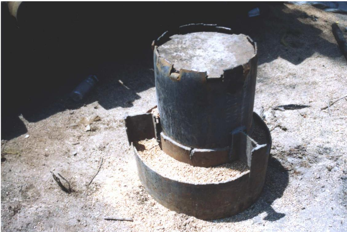
Foto N° 5.- Pozo terminado y cegado temporalmente, listo para su equipamiento, El filtro utilizado para este pozo (Peñón N°6) es de cuarzo  $\phi$  1/16" .
