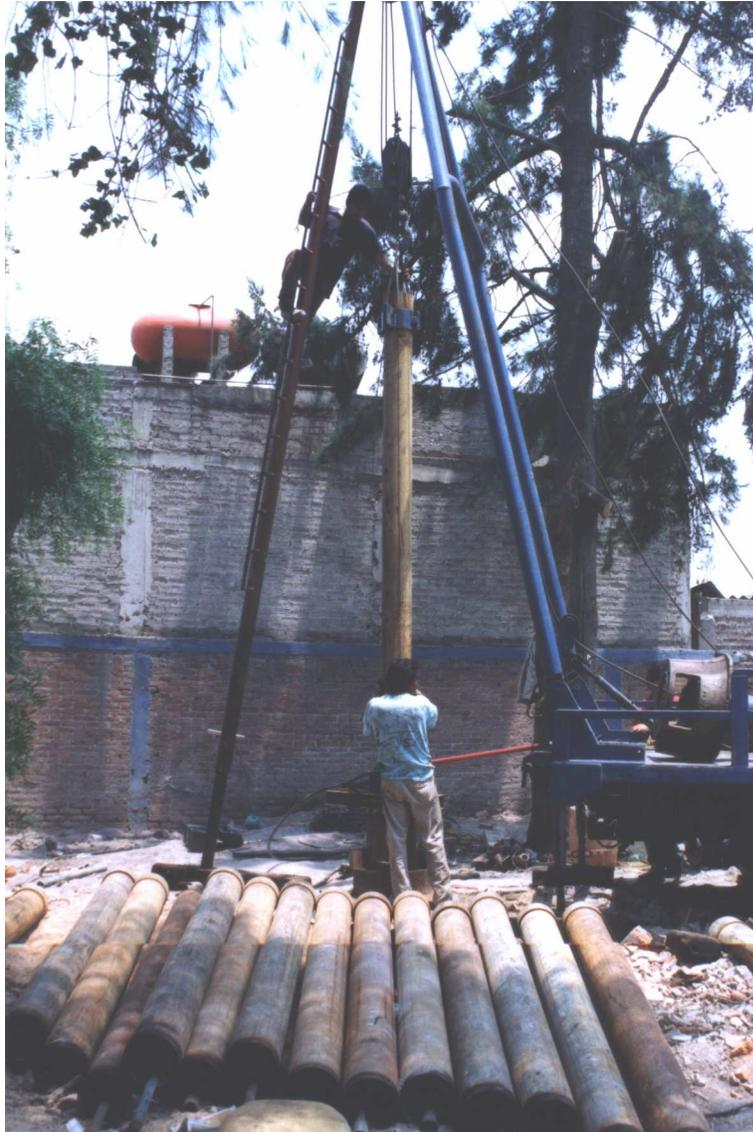
Foto N° 1.- Se observa el armado de tubería de la bomba, con la ayuda de dos personas y un tripie, para el desarrollo y aforo del pozo Peñón N°6.
