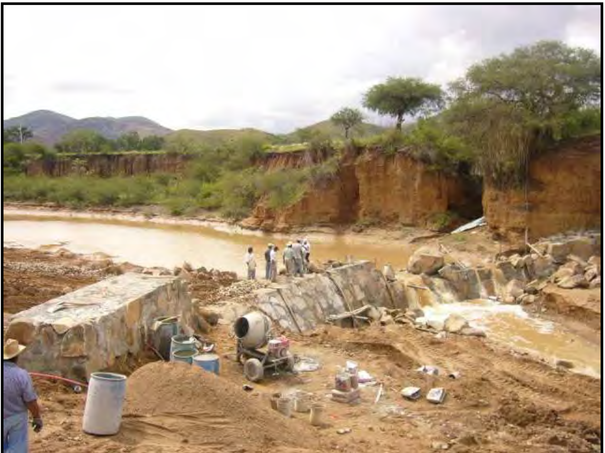
Foto V .1 Proceso constructivo de la primera represa de roca con algunas avenidas en agosto del 2005.
