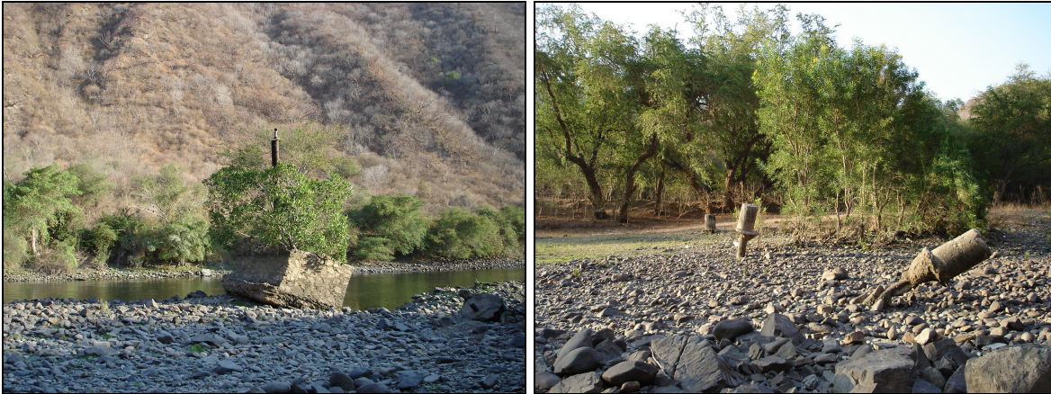
Fotografía 5. Pozos destruidos localizados sobre el cauce del Río Balsas
