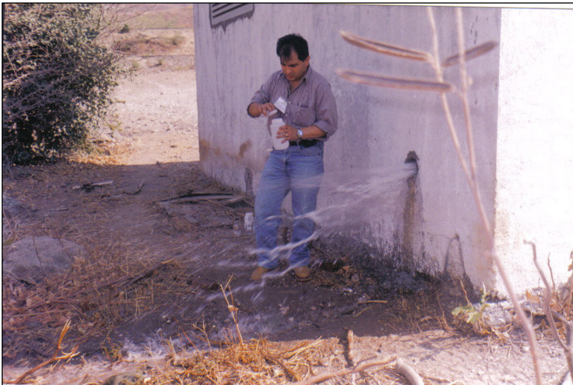
Fotografía 9. Toma de muestra de agua en el pozo P-1
