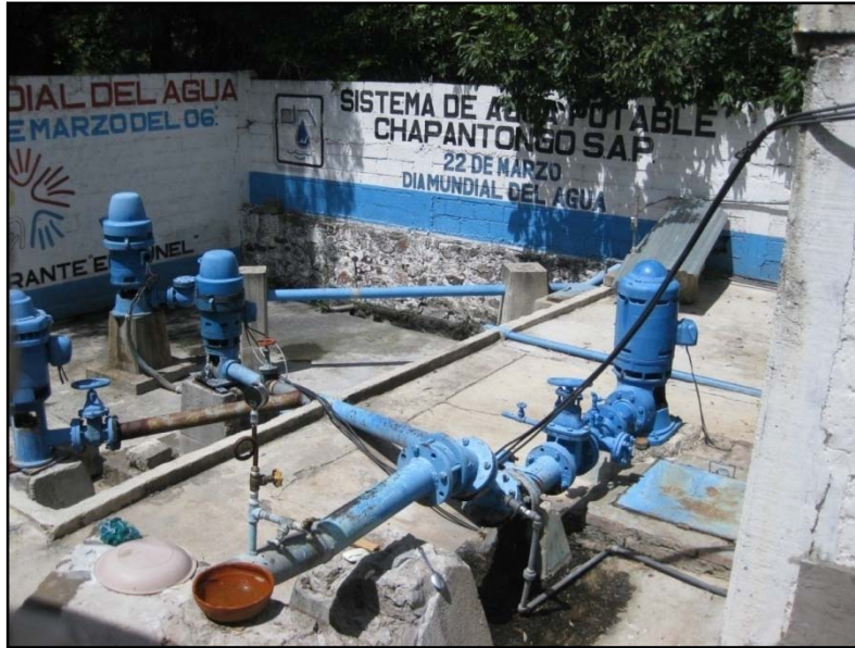
Fotografía V.2. Galería filtrante “El túnel”
