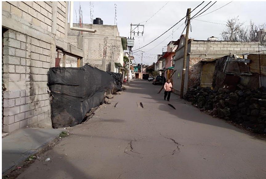
• Figura 22. Hundimiento en la calle Magdalena Moreno.
