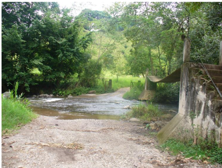
Figura 6. Puente ubicado en el vado Las Monjas (Cortés, 2010).
