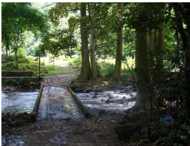
Figura 7. Puente ubicado en el sitio denominado Seis de Enero (Cortés, 2010).
