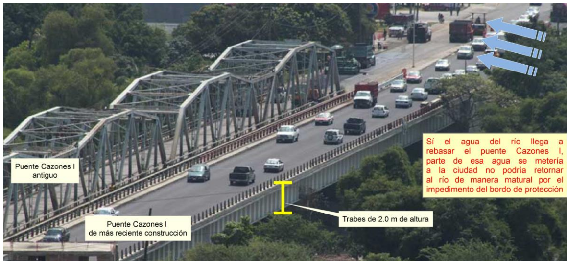
Figura 5. Se observa el puente Cazonos I (antiguo) y el de “reciente construcción” que reduce el área hidráulica del río Cazonos en ese cruce por la nervadura de 2.0 m de altura, que de llegar a rebasar el agua puede penetrar a la localidad de Poza Rica y a la colonia de Plan de Ayala del municipio de Tihuatlán.
