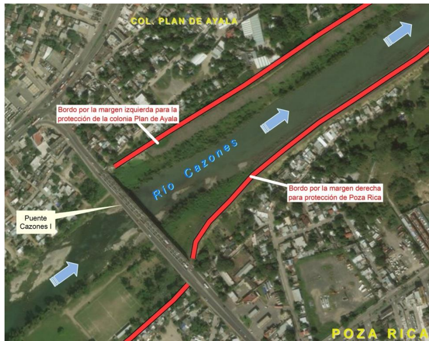
Figura 4. Se observa el puente Cazonés I, marcados en rojo los bordos que protegen a Poza Rica por la margen derecha y a la colonia Plan de Ayala por la margen izquierda.
