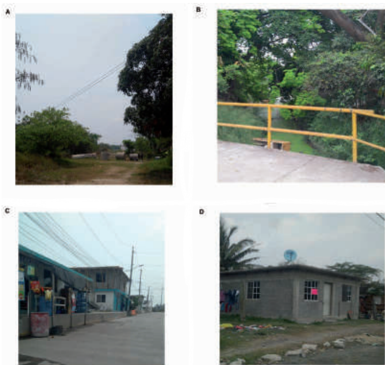
Figura 5. Zonas bajas de la zona cero de Madero: a) colonia Las Flores; b) Arroyo Chipus; c) colonia Las Flores; d) colonia Chipus, Tamaulipas, México, 21 de junio de 2018. Fuente: Elaboración propia con base en trabajo de campo, temporada 2017-2018.
