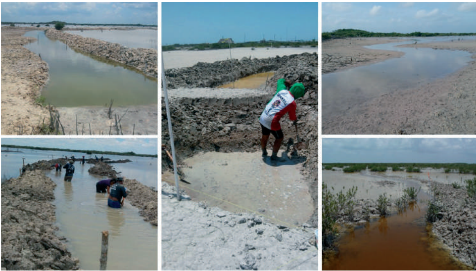
Figura 7. Ejemplos de la rehabilitación o construcción de canales en áreas de manglar degradado. Nótese que el sedimento de los bordes del canal debe dispersarse, y que la trayectoria no debe ser recta, a menos que se trate de un diseño experimental. Autor: Jorge Herrera Silveira.
