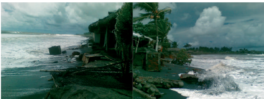
Figura 2. Daños a la infraestructura costera en la comunidad de Puerto Madero, Tapachula, Chiapas.
