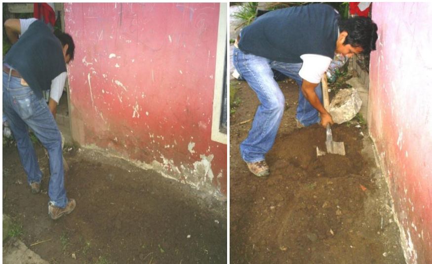
Figura 21. Excavación de pozo, Col. Carolino Anaya.
