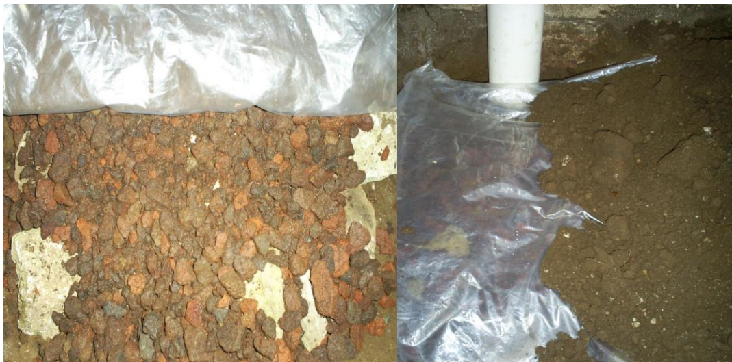
Figura 23. Relleno del pozo con material reutilizado, Col. Carolino Anaya.
