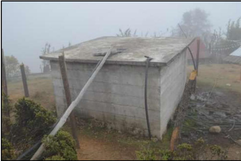
Figura 23. Entrada de la cisterna de almacenaje, se aprecia la manguera principal sujeta mediante un madero (Potrero Nuevo, La Perla).
