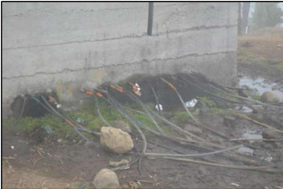
Figura 24. Ramificación de mangueras secundarias en la base de la cisterna (Potrero Nuevo, La Perla).
