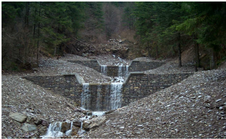
Figura 5. Ejemplo de dique de consolidación
