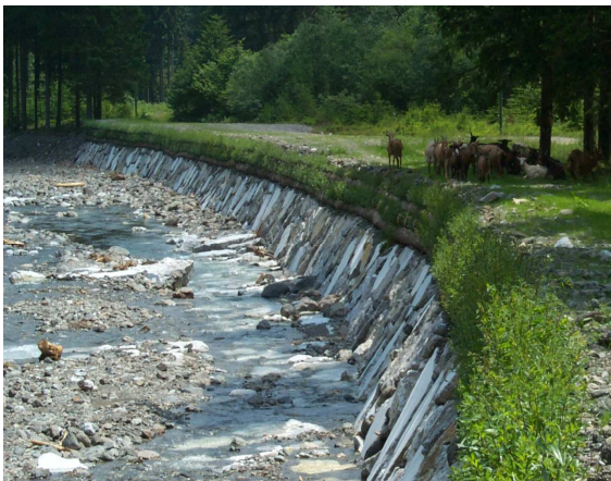
Figura 7. Ejemplo de escollera sobre un cauce
