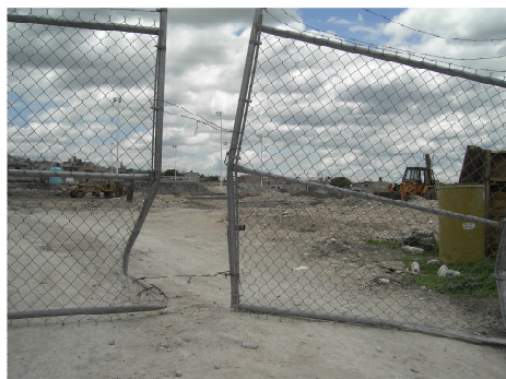
Fig. Proyecto de construcción de parque recreativo y deportivo
