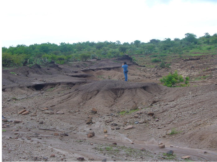
Figura 22. Erosión en Joaquín Herrera (parte alta)
