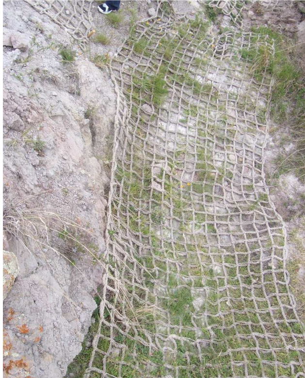
Figura 30. Red 2, se muestra que es un paso de agua por lo cual guarda mayor humedad.
