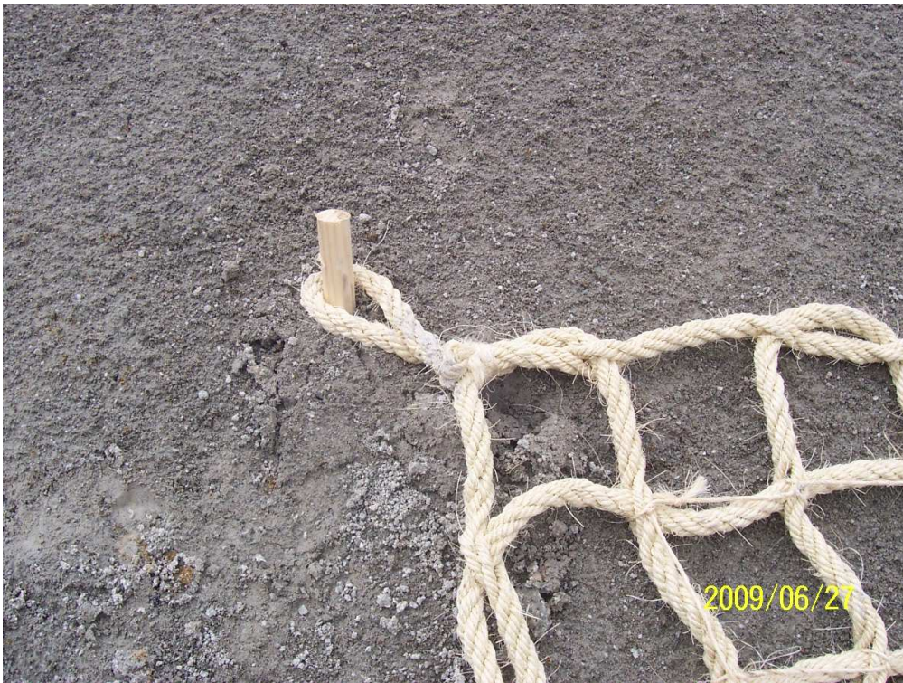
Figura 23. Anclaje de las redes
