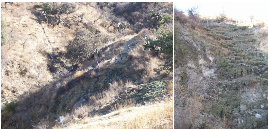
Figura 29. Manantial, cárcamo y escurrimiento hacia el arroyo.
