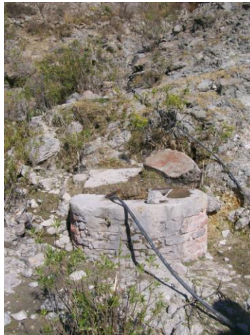
Figura 27. Cárcamo del manantial con mangueras para llevar a agua.
