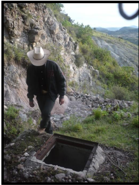
Figura 14. Obra de almacenamiento y distribución del agua del manantial del Pelón, del periodo de Antonio Calzada, abandonada. LEG, 2010.
