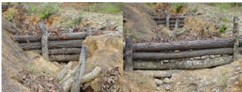
Figura. 21. Ejemplos de presas de morillos.
