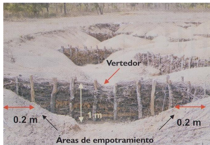
Figura.20. Diseño de presa de ramas en cárcavas.
