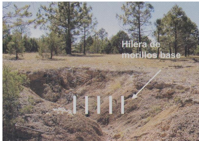
Figura.22. Establecimiento de hilera de morillos base.
