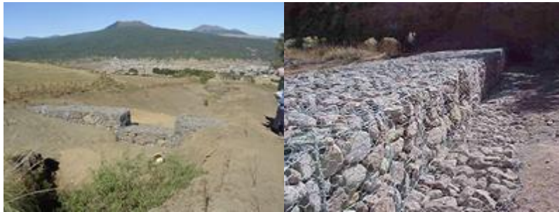
Figura. 36. Ejemplos de presas de gaviones.
