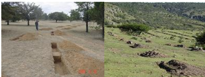
Figura.46. Ejemplos de tinajas ciegas (zanjas trinchera)
