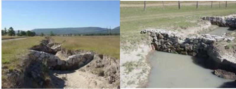
Figura.25. Ejemplos de presas de piedra acomodada.
