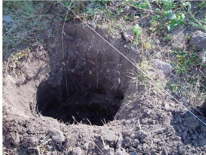
Figura.59. Excavación de la cepa de siembra.
