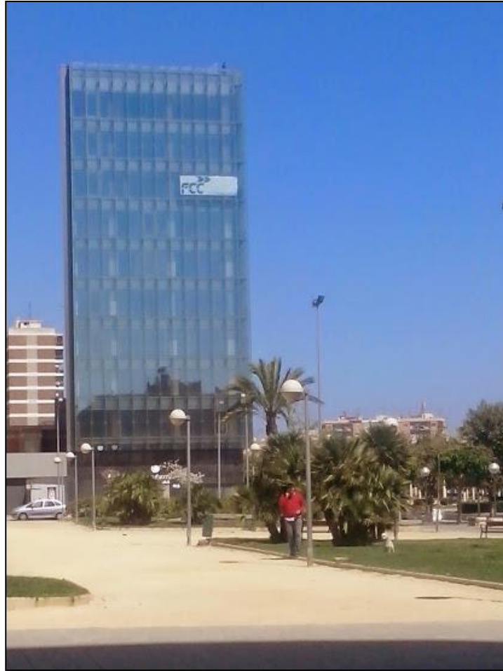
Ilustración 12.- Edificio Fomento de Construcciones y Contratas FCC en la ciudad de Alicante, España. 15 de abril de 2014. Foto: Luis Enrique Granados Muñoz.
