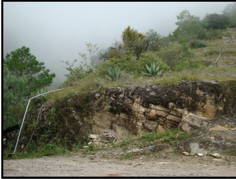
Ilustración 28.- Tubos sin agua en la comunidad de El Timbre, a un costado la manguera de la comunidad. Foto: Luis Enrique Granados Muñoz. Septiembre de 2014.
