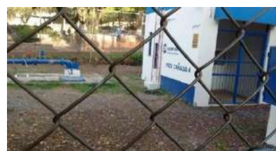
Ilustración 4.15 Bomba de la CEA ubicada a espaldas del balneario El Piojito, Ilustración 4.16 Pozo de la CEA ubicado a un costado de la Alberca del Capulín.
