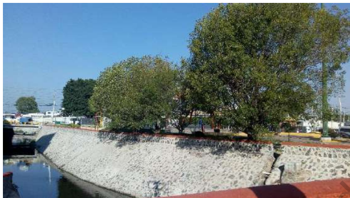
Ilustración 3.6 Presa de céspedes, construida en el siglo XVI. Hoy Av. Universidad esquina con Av. 5 de febrero. Fotografía tomada en agosto 2019.
