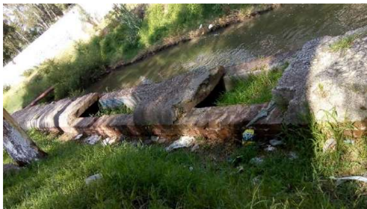
Ilustración 4.30 Fragmento del Acueducto porfiriano construido a inicios del siglo XX. Fotografía tomada en agosto 2018.
