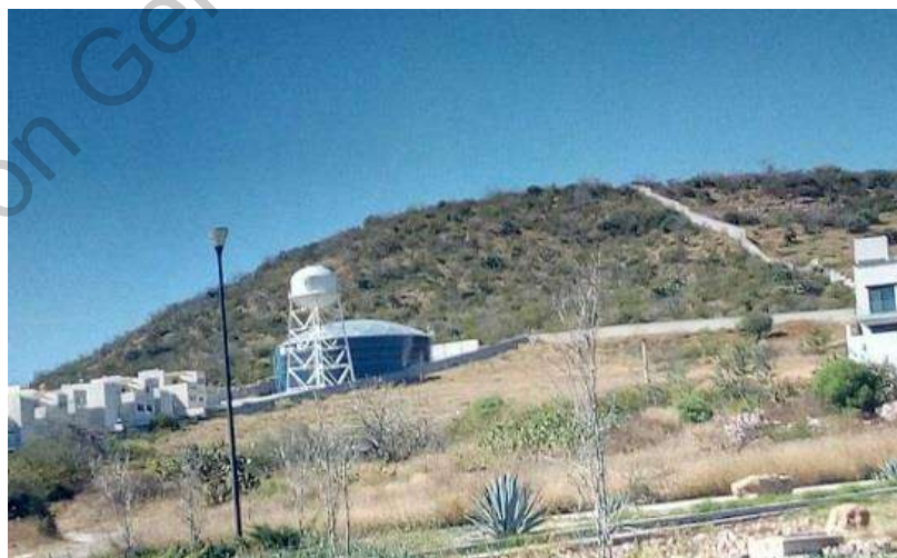
Ilustración 5.2 Pozo operado por Provincia Juriquilla. Fotografía tomada en mayo 2019.
