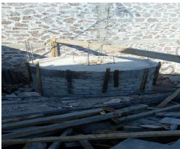
Ilustración 4.111 Cisterna de tabique impermeabilizado. Fotografía tomada en abril 2019.
