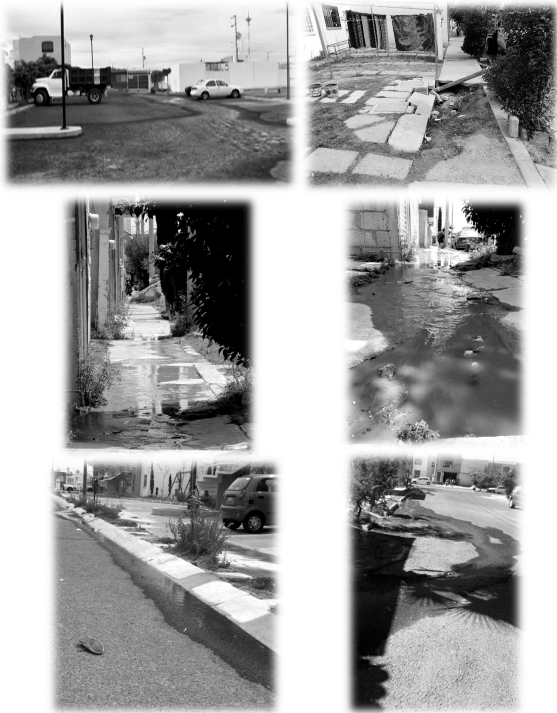
Figura 69. Fugas en calles de La Pradera. Fuente: Fotografías propias.
