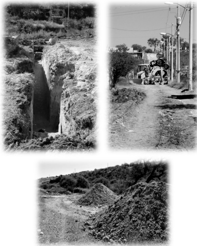
Figura 97. Línea de drenaje Zibatá-El Pozo. Obras de construcción y ampliación de línea del drenaje Zibatá – El Pozo. Fuente: Fotografías propias.
