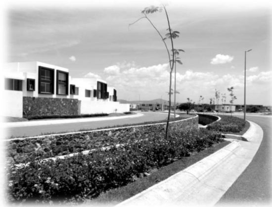
Figura 54. Drenes pluviales como articuladores del espacio. Fuente: Fotografía propia.
