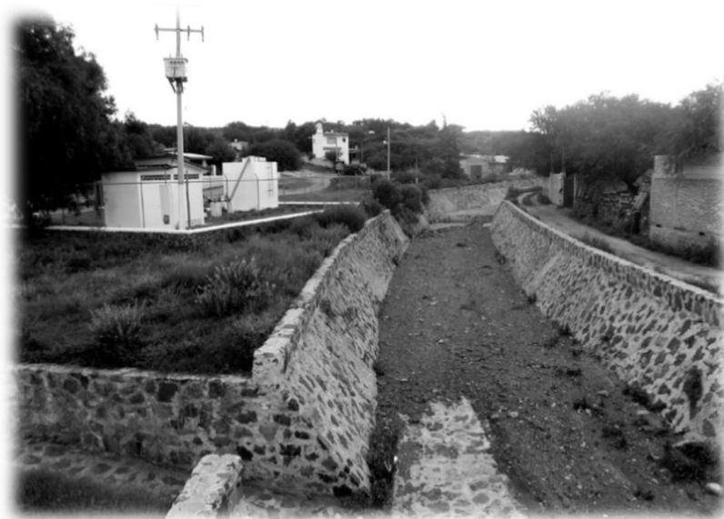
Figura 92. Arroyo – dren pluvial. Aspectos del dren desde su nacimiento en El Refugio y La Pradera, su cauce y su llegada a la localidad (junto al pozo de agua potable). Fuente: Fotografías propias.
