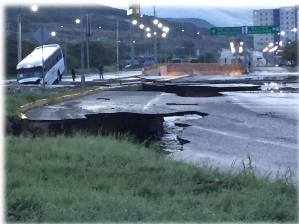
Figura 37. Paradojas del "Querétaro (pos)Moderno". Redes de infraestructura socavadas por las lluvias frente en las inmediaciones de Antea LifeStyle Center y los dominios de DRT (septiembre 2017).
