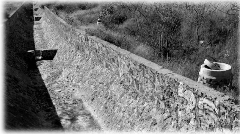
Figura 95. Dren pluvial y drenaje de aguas negras. Fuente: Fotografía propia.
