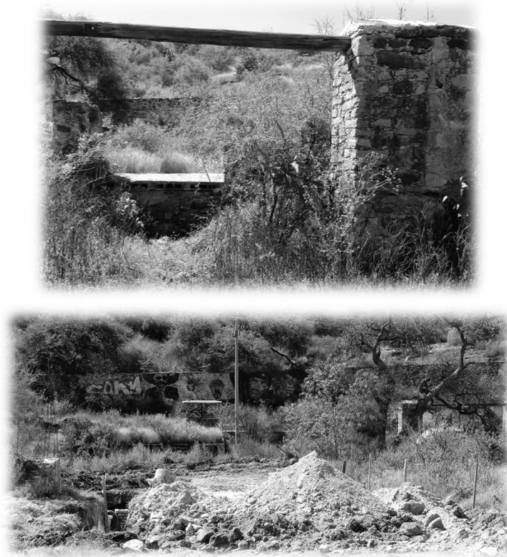
Figura 98. Antiguo pozo, atarjea y línea de drenaje Zibatá – El Pozo. Fuente: Fotografía propia
